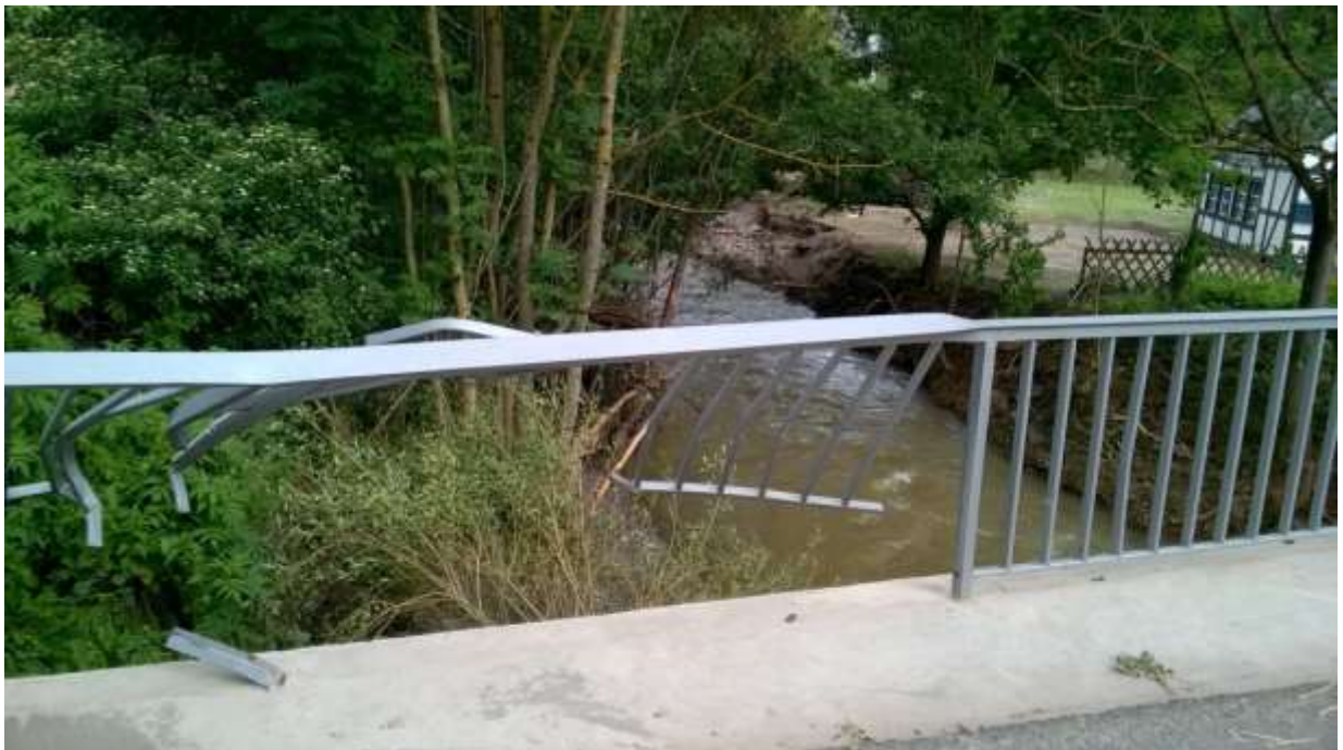
Abbildung 14: Zerstörtes Brückengeländer kurz oberhalb des Pegels Gerach am Fischbach (Copyright: LfU).
