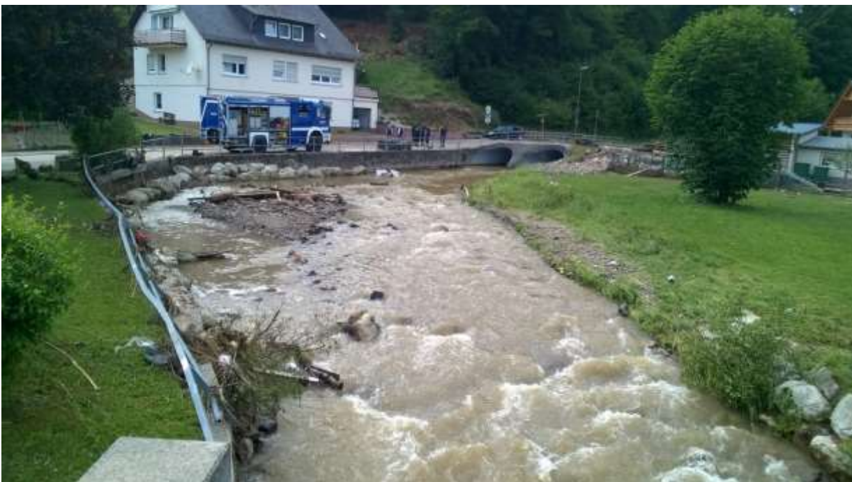
Abbildung 12: Zerstörte Ufergeländer in Herrstein am Fischbach (Copyright: LfU).
